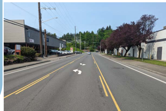
Woods Creek Road resurfacing project completed in 2022. El proyecto de repavimentación del Woods Creek Road finalizó en 2022.
